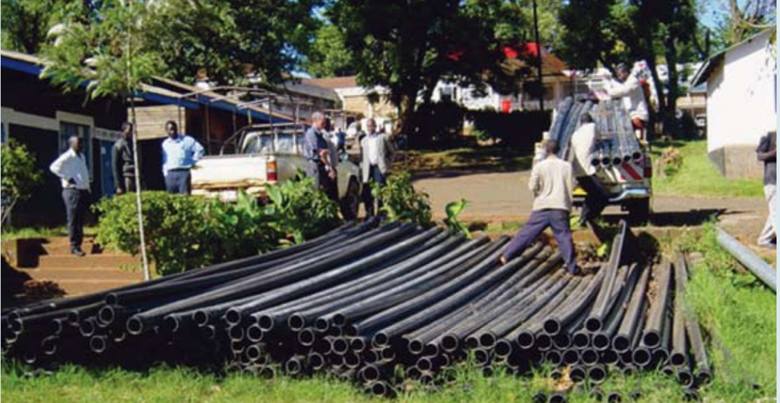
Livraison de conduits pour l'adduction d'eau à Kisii (Kenya) Photo @ ONU-HABITAT
