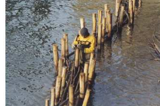
Mise en place de la fascine
