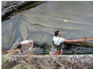
Mise en place du bidim
