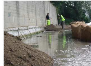
Apport de terre végétale
