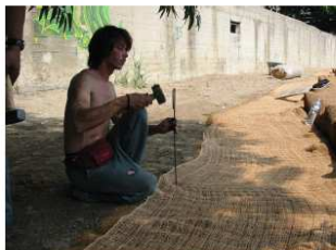
Fermeture du géotextile coco
