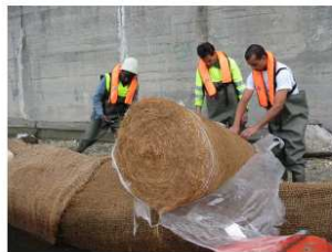
Mise en place du géotextile coco
