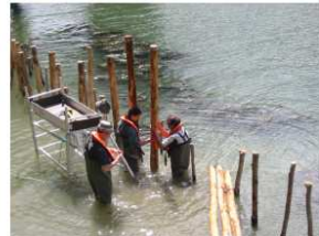
Fonçage des pieux
